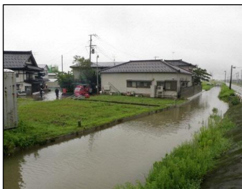
[二丁堀排水機の整備状況]
