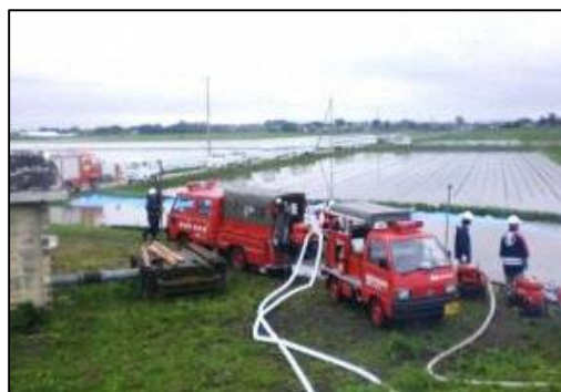
[長沼排水機の整備状況]
