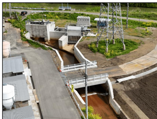
排水機（令和 5 年度完成）
