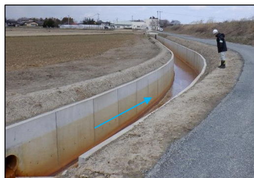
排水機（令和 4 年度完成） 導水路（令和 5 年度一部完成）
