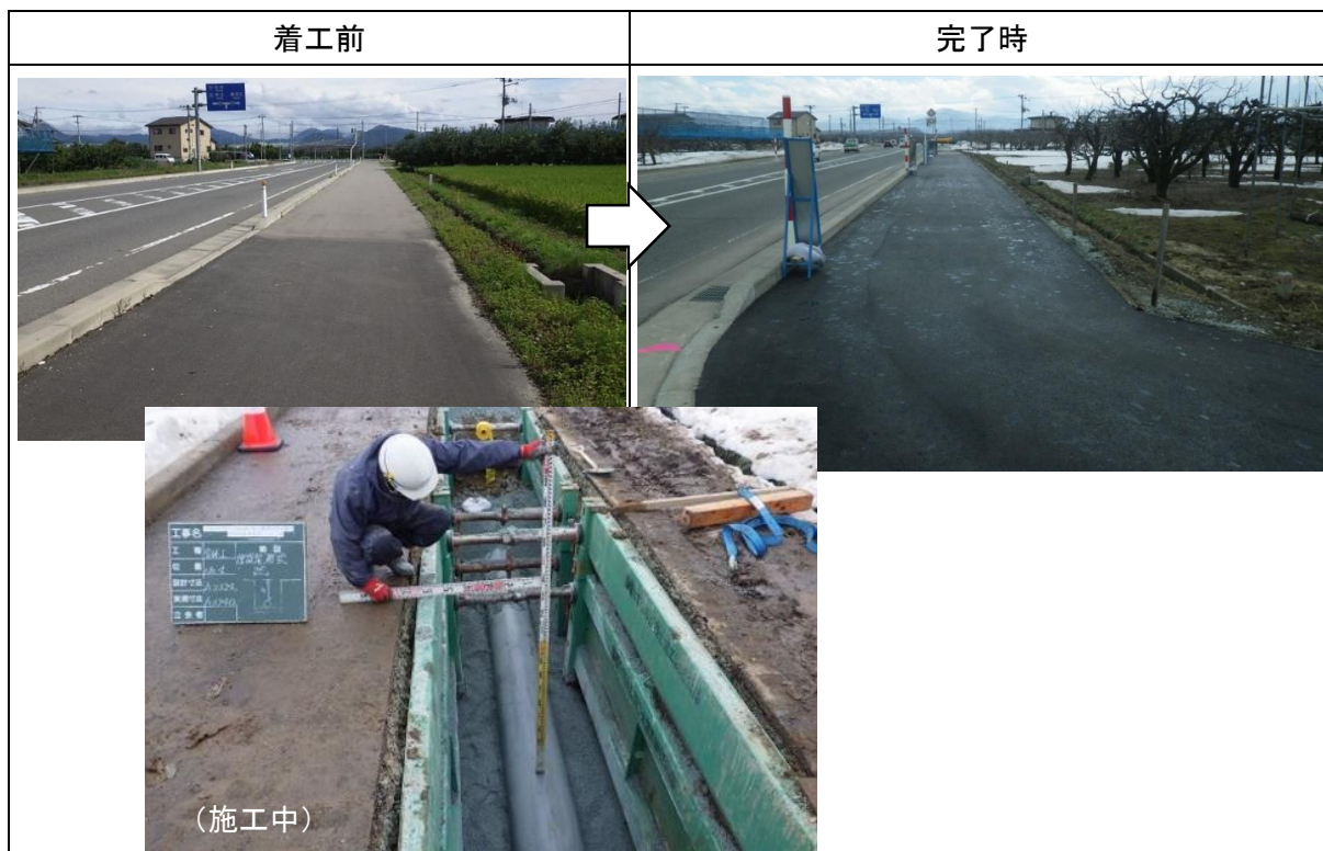
[送水管布設状況 (枝線 VM 直径 400mm)]
