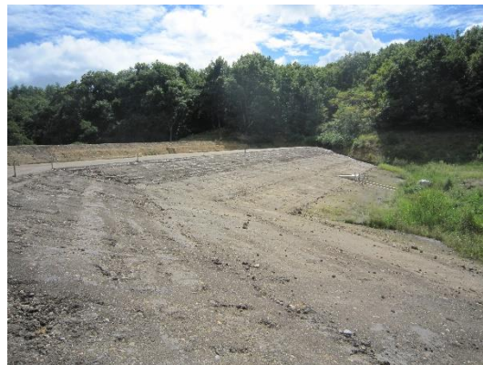
整備中（堤体盛土）
