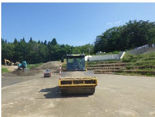
対策実施状況（堤体盛土）
