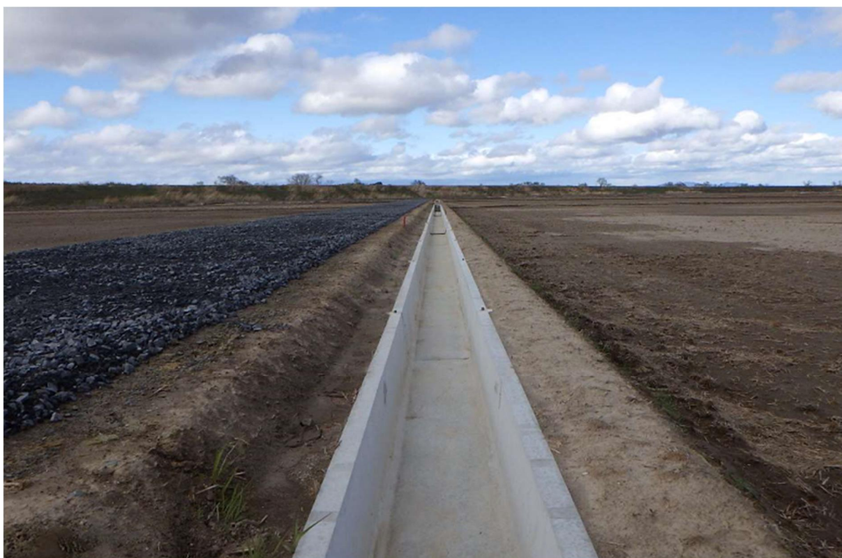
用水路工（区画整理後）
