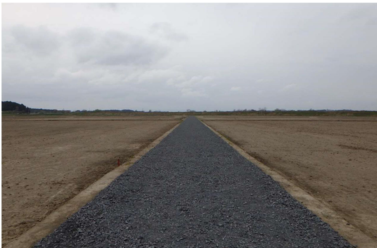
支線道路（区画整理後）
