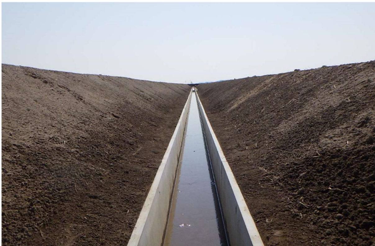
排水路工（区画整理後）
