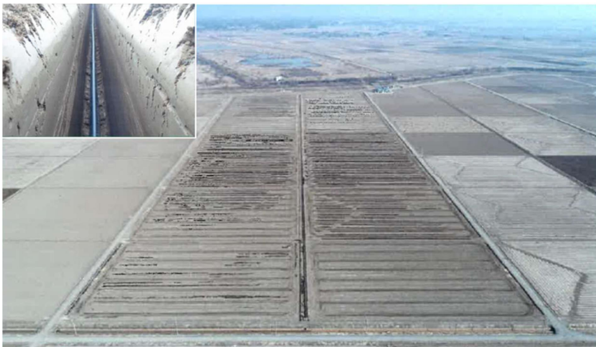
暗渠排水路工（区画整理後）
