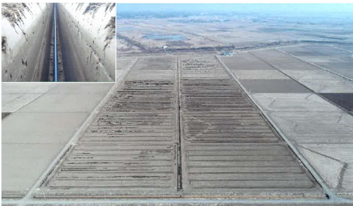
暗渠排水路工（区画整理後）
