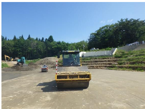
対策実施状況（堤体盛土）
