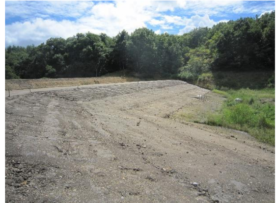
整備中（堤体盛土）
