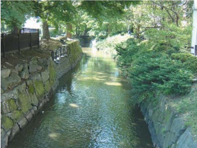
取水時の七郷堀（若林区役所前）
