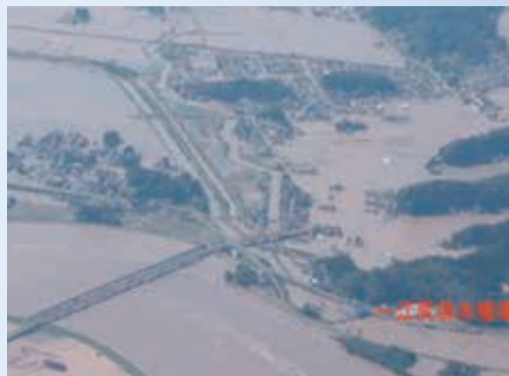
【令和元年東日本台風時 江尻排水機場周辺】
