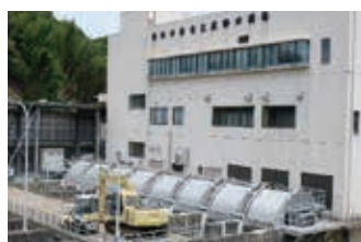
①江尻排水機場除塵設備製作据付工事
