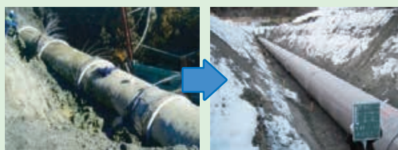
【幹線用水路の改修(管入替え)】
