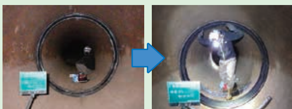
【幹線用水路の継手改修(止水バンド)】
