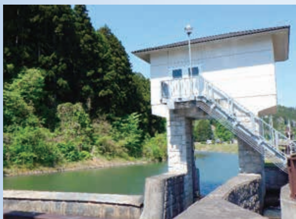
【日和田頭首工】
