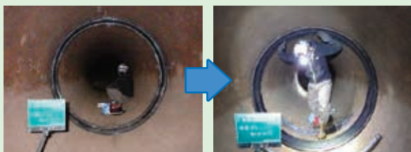
【幹線用水路の継手改修(止水バンド)】
