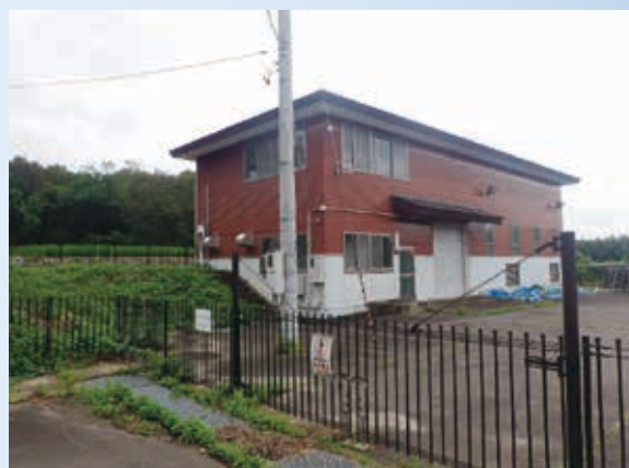
【隈戸揚水機場】
