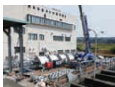
①江尻排水機場除塵設備製作据付工事
