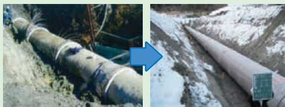
【幹線用水路の改修(管入替え)】
