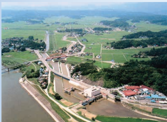
【江尻排水機場上空】
