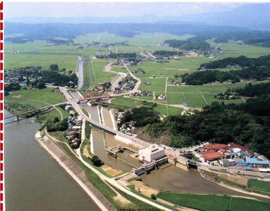
【江尻排水機场上空写真（角田市）】
