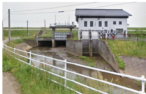
【堀切排水機場（丸森町）】
