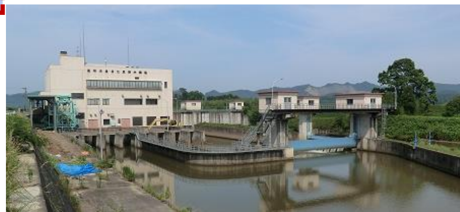
【江尻排水機場（角田市）】
