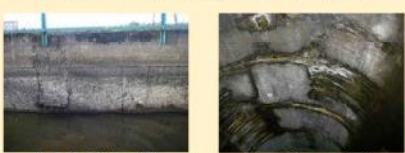
【開水路側壁】 【トンネル上部】
