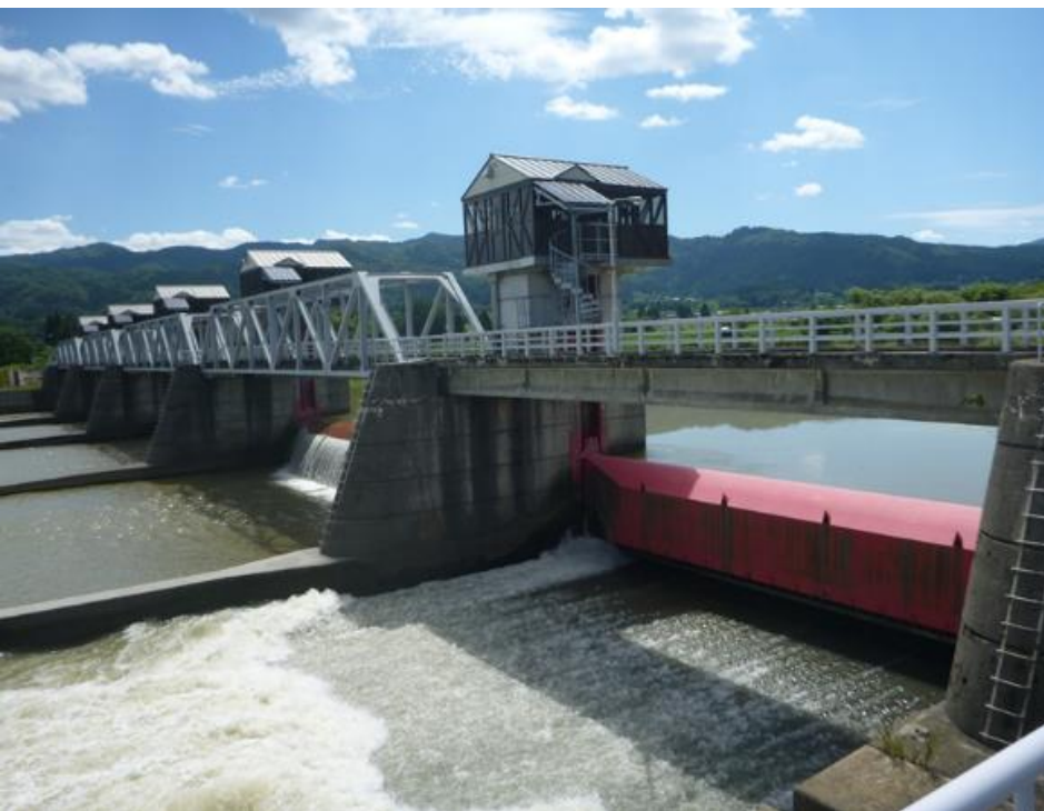
土砂吐・洪水吐ゲート設備の更新
