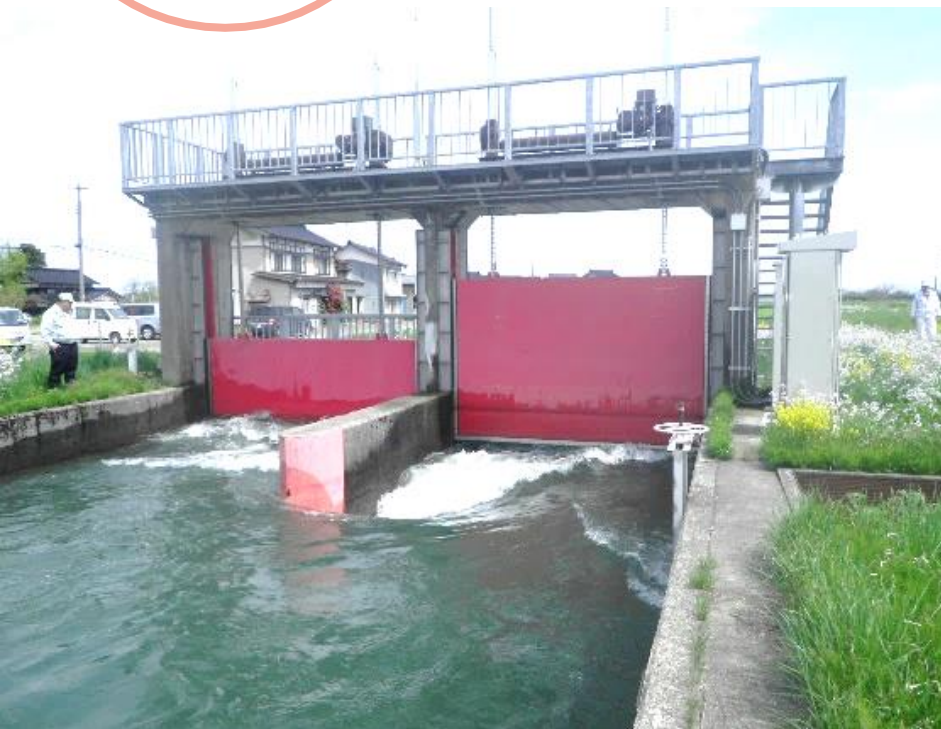
ゲート設備の整備（板井川分水工）
