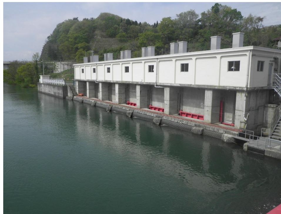
取水・制水ゲート設備の更新
