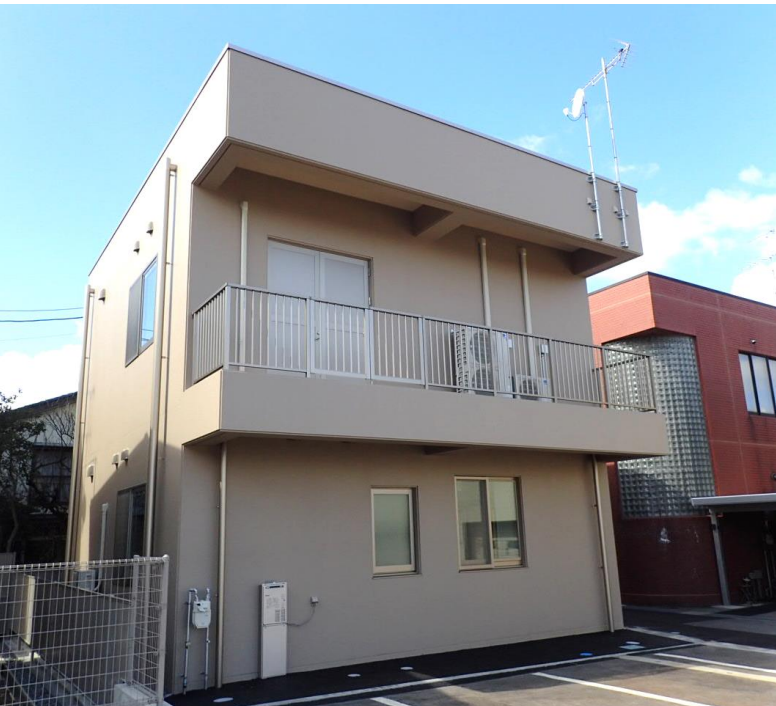
赤川用水管理センター
