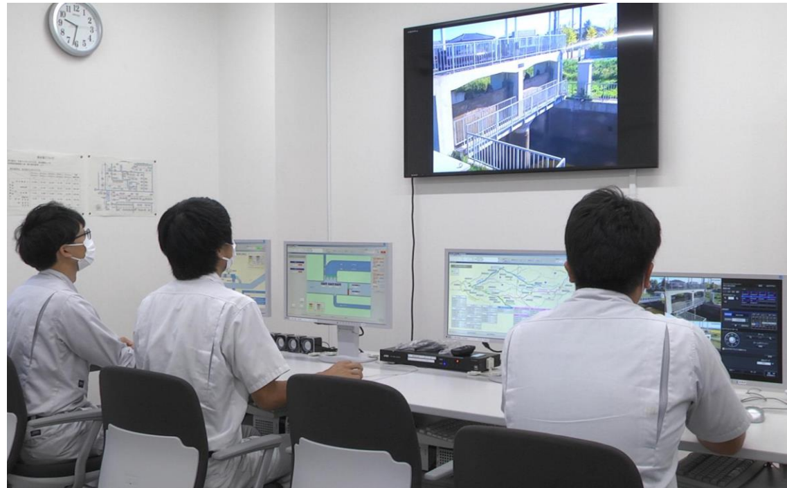
赤川用水管理センター（操作室）
