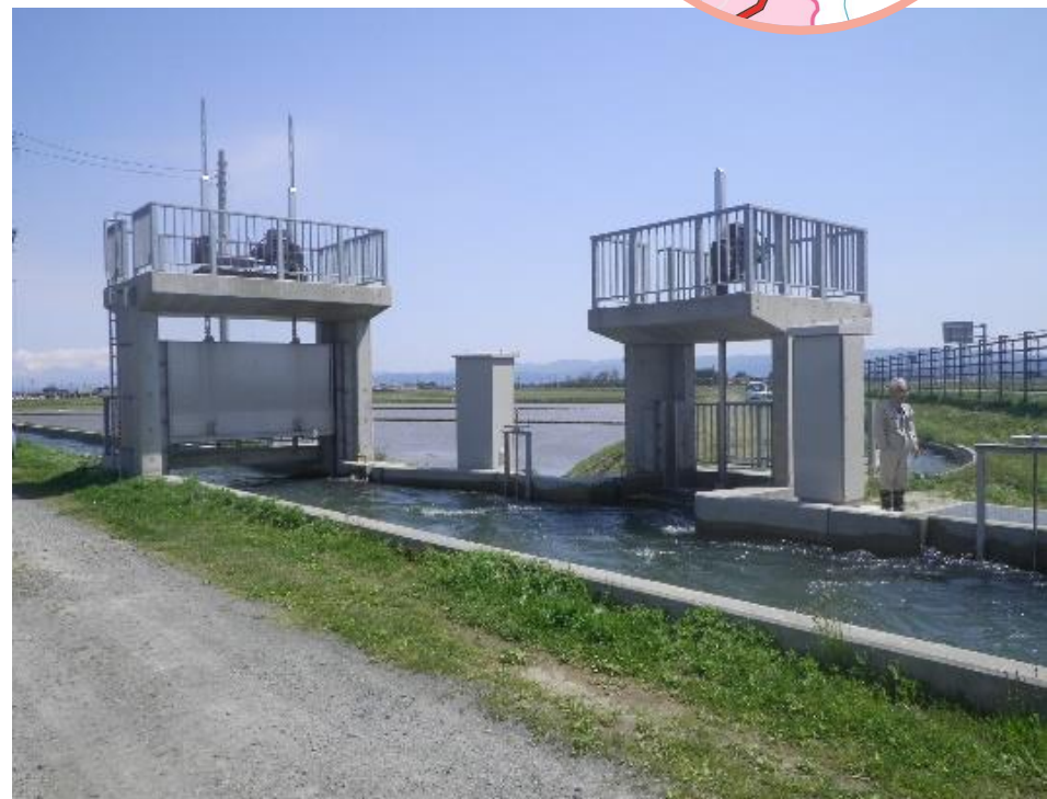
分水工の改修（東五ヶ村分水工）
