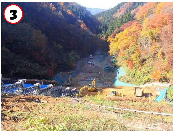
③堤体盛立材運搬仮設(ベルトコンベア)の状況 (ダム天端から望む) (R4.11.11 撮影)
