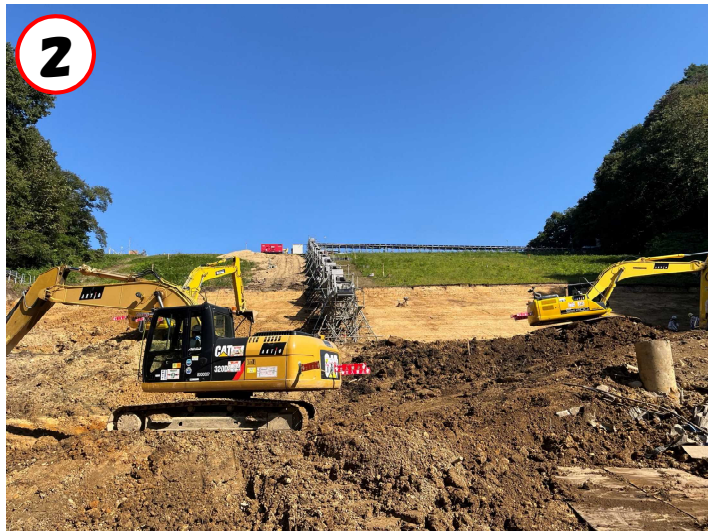
②現堤体掘削の状況(ダム下流側から望む) (R4.9.30 撮影)
