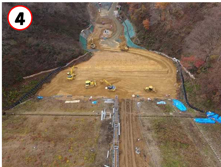
④タンピングローラーによる転圧、バックホウ・ブルドーザ によるまき出し、法面バケット付バックホウによる 法面整形の各作業状況(ダム天端上空から望む)(R4.11.21撮影)
