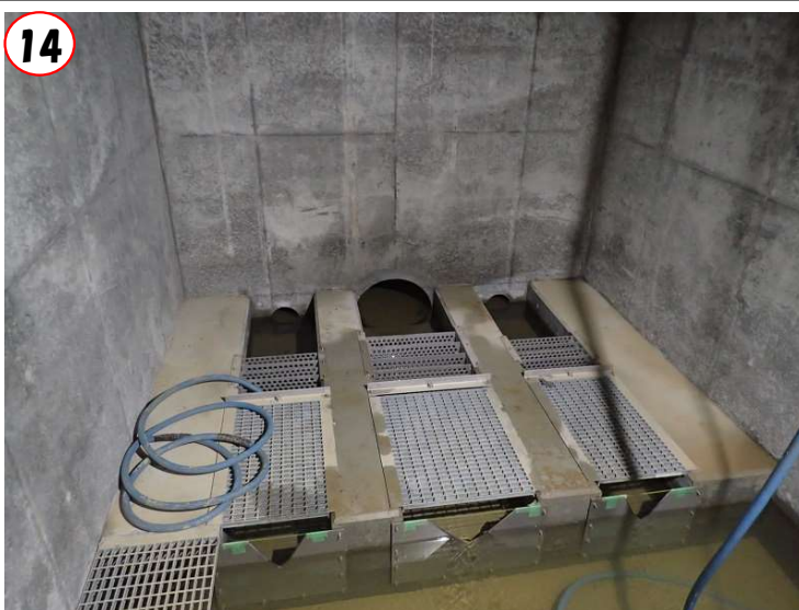
⑭堤体下流に設置した浸透量観測施設 (R5.7.24撮影)
