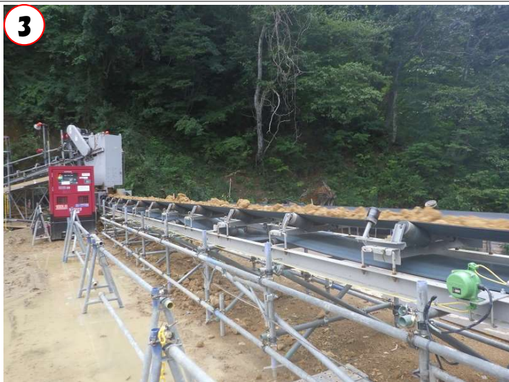
③堤体盛立材運搬仮設(ベルトコンベア)の状況 (ダム天端付近) (R5.9.19 撮影)
