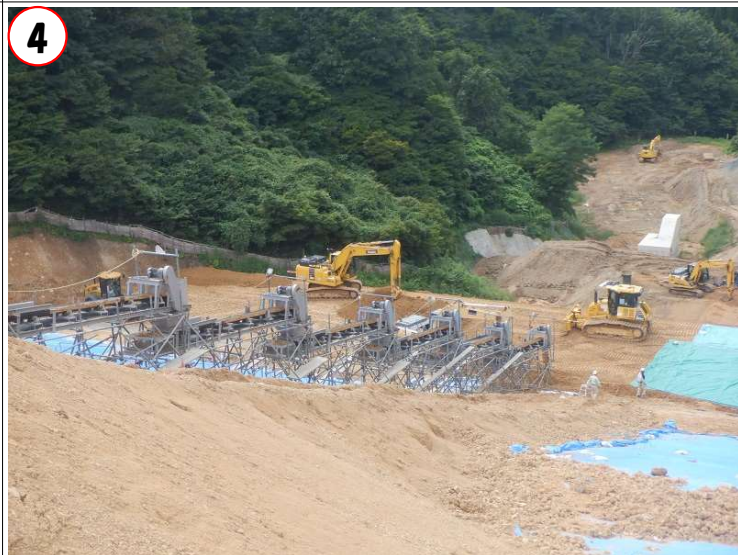
④ベルトコンベアによる土砂運搬、バックホウ・ブルドーザ によるまき出し作業状況(ダム天端から望む) (R5.9.8撮影)
