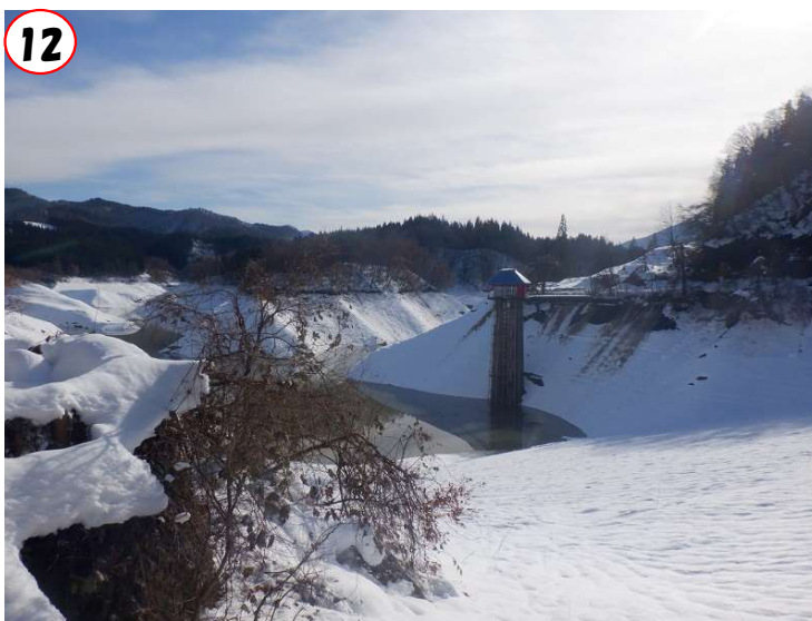
⑫越冬時の状況(ダム天端から望む) (R5.11.30撮影)
