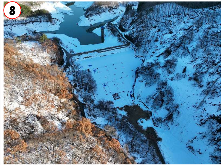
⑧越冬時の状況(ダム下流側上空から望む) (R5.12.6撮影)
