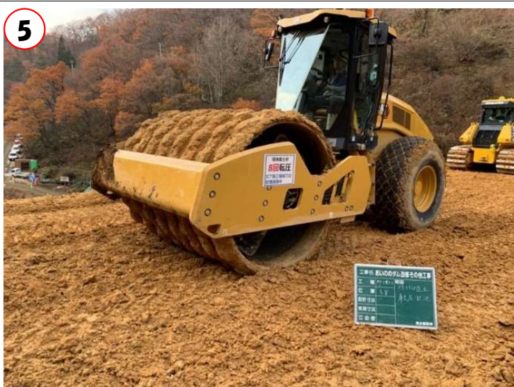
⑤タンピングローラーによる盛立・転圧作業状況 (R5.9.5撮影)
