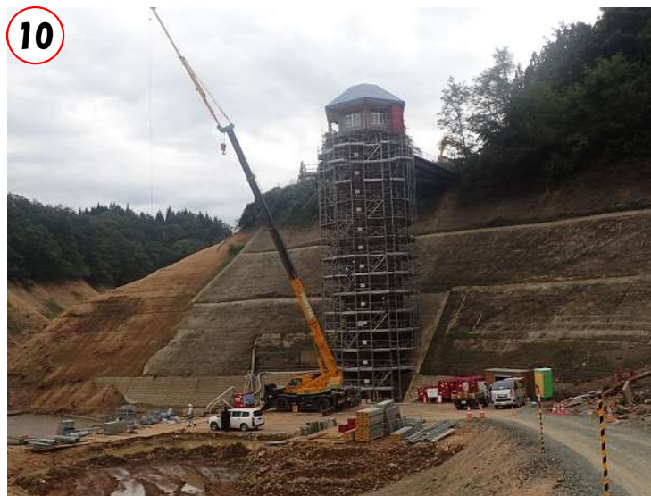
⑩取水塔耐震補強工事の状況(ダム湖底から望む) (R5.9.26撮影)
