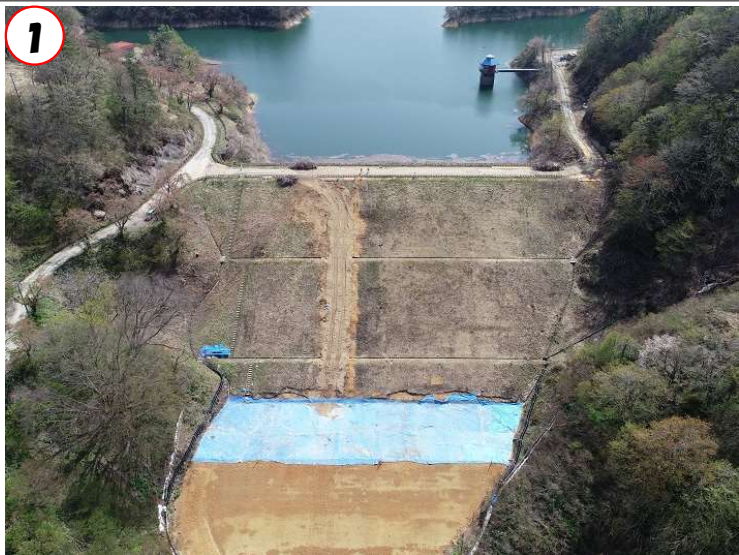
①R5年度施工開始前の状況(ダム下流側上空から望む) (R5.4.28 撮影)
