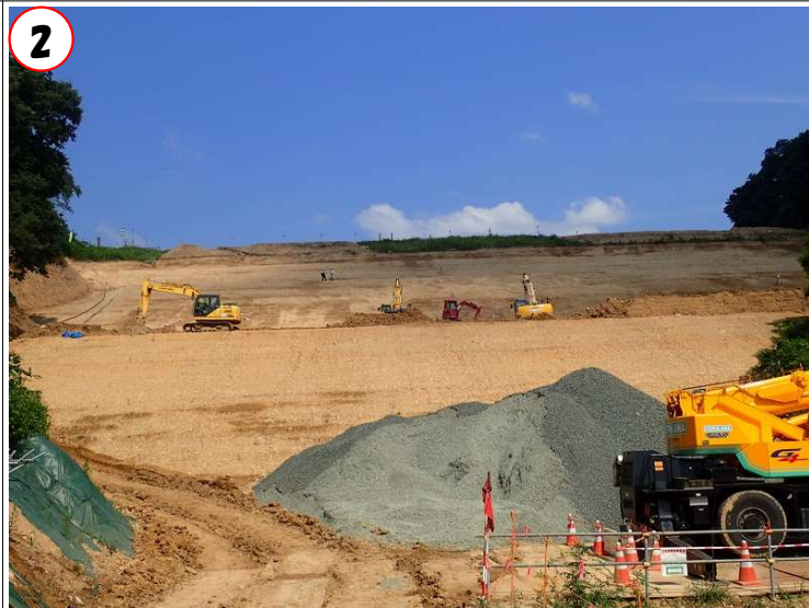
②現堤体掘削の状況(ダム下流側から望む) (R5.7.24 撮影)
