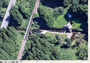
黒沢川頭首工
