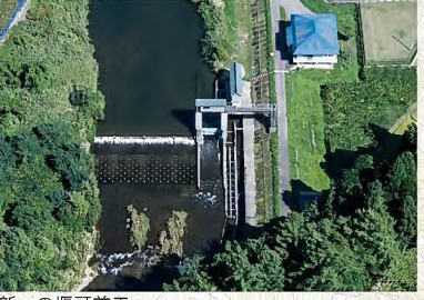
新一の堰頭首工
