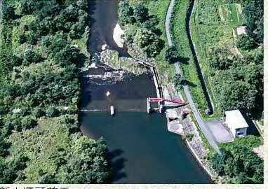
新上堰頭首工
