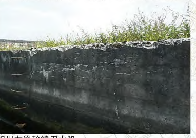
旭川左岸幹線用水路
