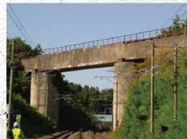
D IGR水路橋
