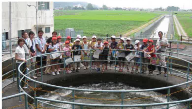
前谷地揚水機場(円筒分水工)
