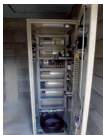
アンカー・TCTM子局装置の施工状況
