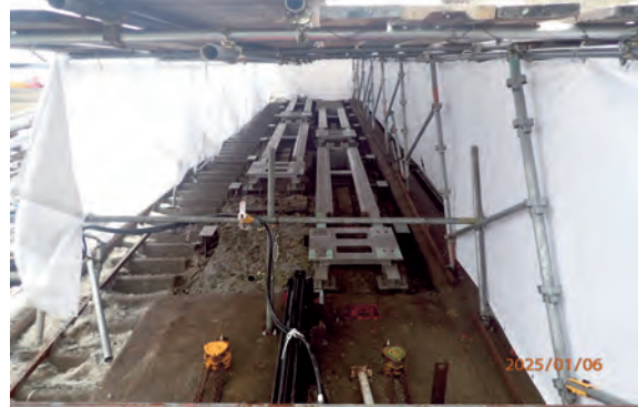
取水施設のゲート設備更新（施工中）
