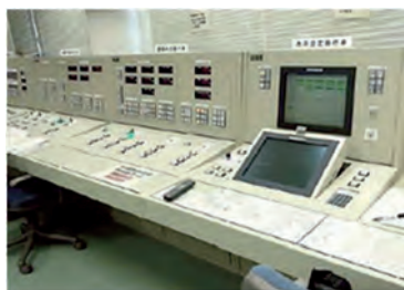
▲【監視操作卓】耐用年数の超過（交換部品調達不可）
