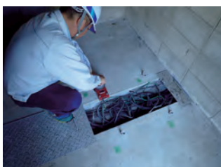
アンカー・TCTM子局装置の施工状況
