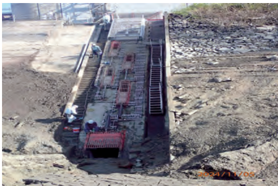
取水施設のゲート設備更新（施工前）
