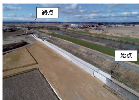
簗岳幹線用水路（その4）工事（施工後）
