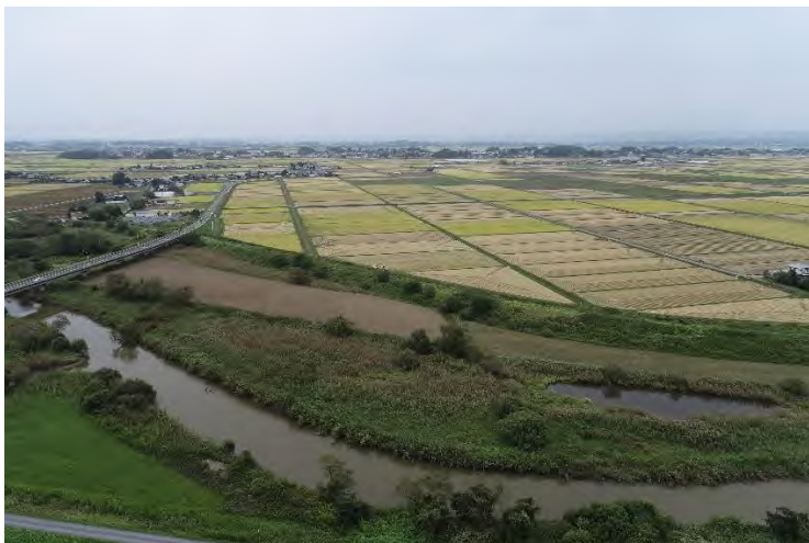
西幹線排水路予定地概況 機場整備予定地南側から北側を撮影
