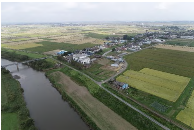
米山揚水機場概況 現行機場北側から撮影
