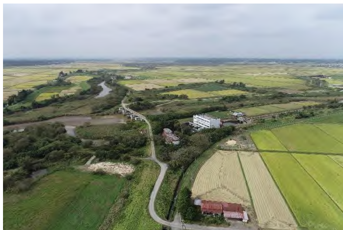
南方揚水機場概況 現行機場南東側から撮影
