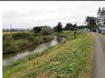
取水口付近概況(荒川)
