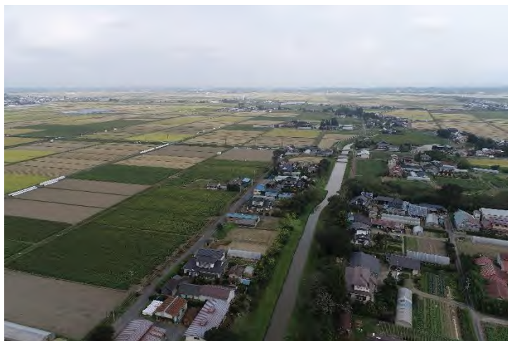
米山幹線排水路概況 現行機場北側から撮影
