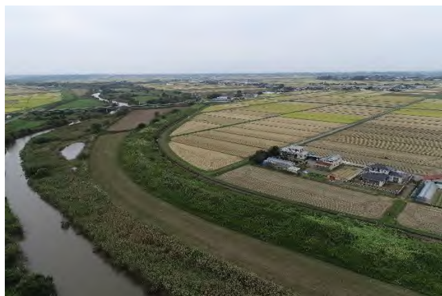
西排水機場予定地概況 機場整備予定地南東側から撮影
