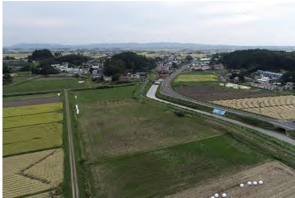
高石揚水機場概況 機場整備予定地北側から撮影
