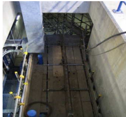
搬入口（開口部）モノレール施工後
