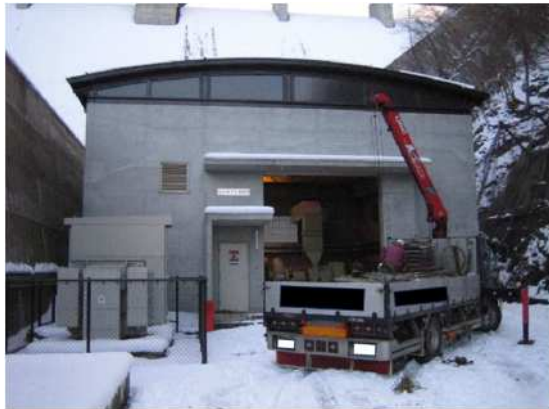
敷材搬入状況 1
