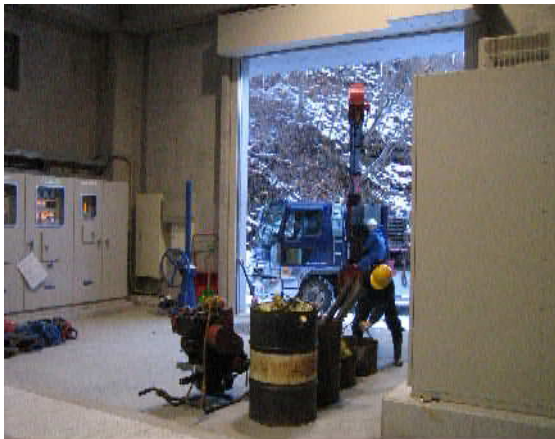
敷材搬入状況 2
