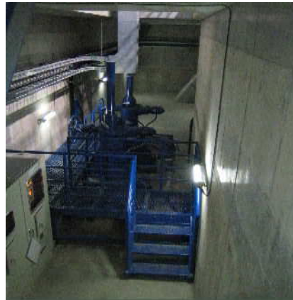
搬入口（開口部）モノレール施工前
