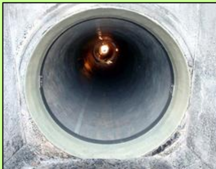
用水路の補修補強 (用水安定供給)
