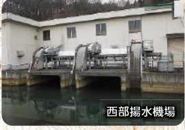
西部揚水機場
