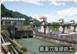
鹿妻穴堰頭首工
