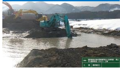
堆砂除去工事の施工状況
