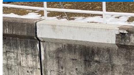
改修後の余水吐
