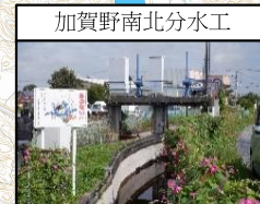
加賀野南北分水工
