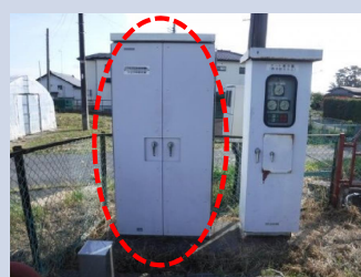
【TM/TC子局装置】 対応年数の超過 部品調達ができない
