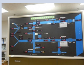
【監視表示盤】 対応年数の超過 数値が表示されない
