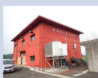
【排水機場】 中央管理所からの操作 ができない
