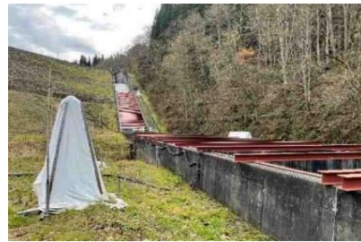
側壁の傾斜と仮設梁の設置
