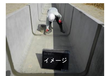
機能低下が生じている施設の改修
