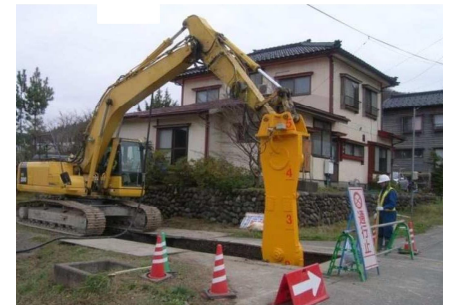
耐震化（セメント改良工法）の住宅近接施工事例
