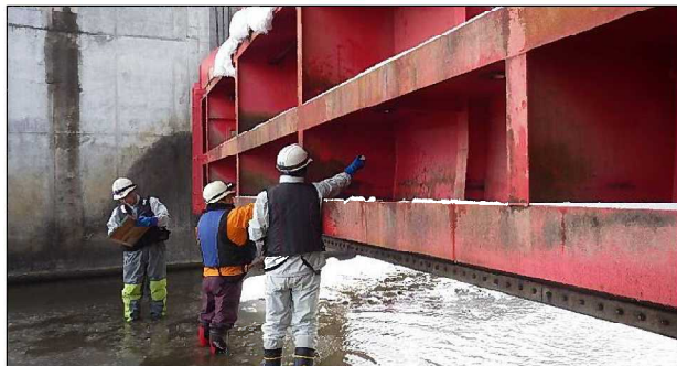
▲ゲート設備の機能診断調査（板厚測定：虹貝頭首工）
