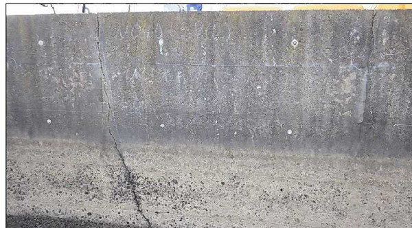
▲用水路の機能診断調査（概略診断調査：東俣2号幹線用水路）
