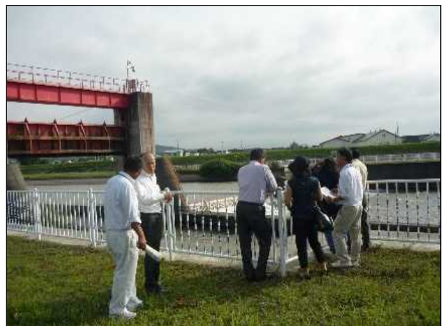
▲浅瀬石川第一頭首工（浅瀬石川二期地区）
