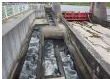
▲浅瀬石川第一頭首工(魚道)
