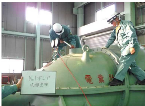
▲生田揚排水機場 内視鏡による内部調査
