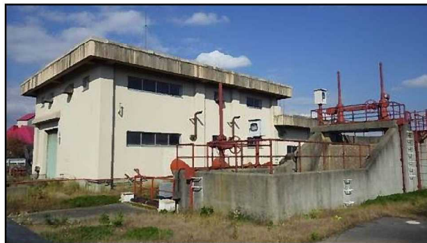
▲川倉揚水機場
