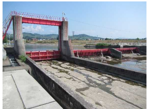
▲浅瀬石川第一頭首工
