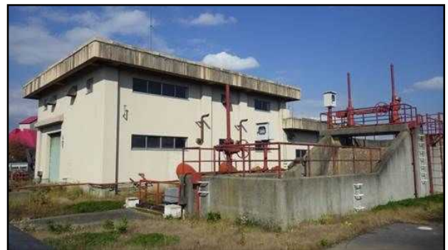
▲川倉揚水機場（整備前）
