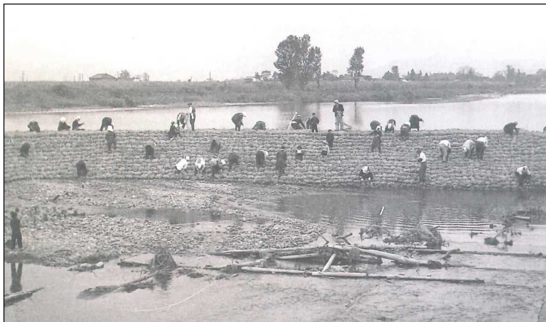
▲昭和 33 年以前の俵積み（護岸造成）
