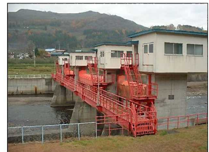
▲温湯頭首工（浅瀬石川地区）
