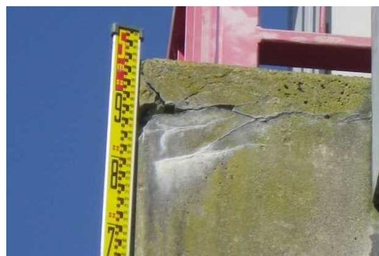
▲尻無頭首工 操作台端部のクラックと欠損
