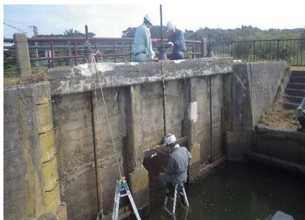
写真-2 ゲート開閉確認立会いの様子 (R3 機能保全計画策定業務)
