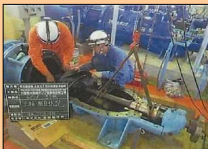
ポンプ分解整備状況
