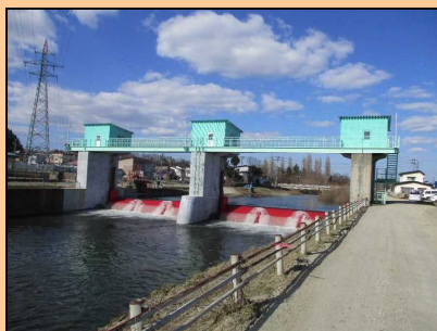
全景（左岸下流より）
