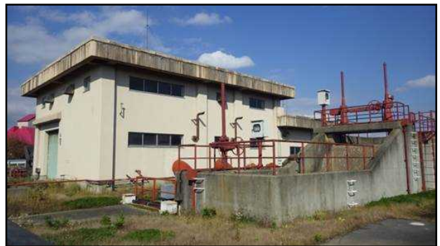
▲川倉揚水機場
