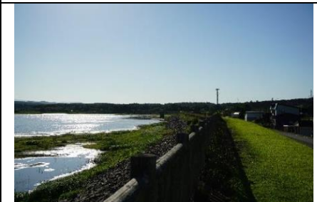
第1取水塔遠景
