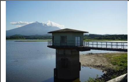
第1取水塔近景
