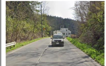
ダム管理棟 中景
