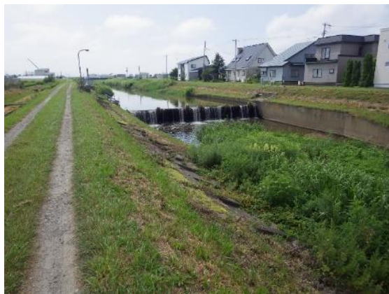
松島頭首工概況
