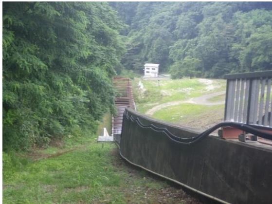
浪岡ダム洪水吐概況 (洪水吐上流側から撮影)
