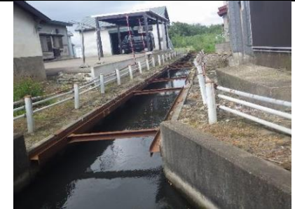
近景 (ガードパイプ)
