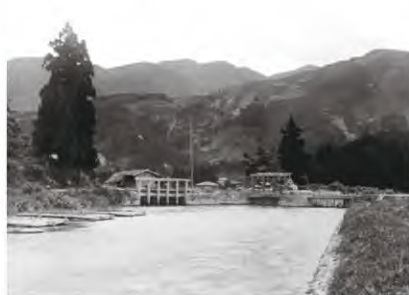
明治後期の旧北楯頭首工
