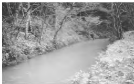
国営事業改修前の北楯大堰用水路
