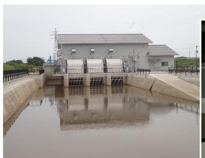
中央排水機場 全景
