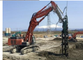
中央排水機場基礎工施工(R2年2月)
