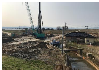
毒蛇排水機場基礎工施工(R2年3月)
